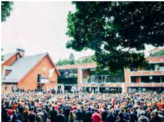
Även inne på Chalmersområdet finns F O Peterson representerade. De låg nämligen bakom uppförandet av nya kårhuset på Chalmers som stod färdigt 2002. 12 000 kvm nya adderande efterlängtrade ytor skapades för Chalmers studenter.
