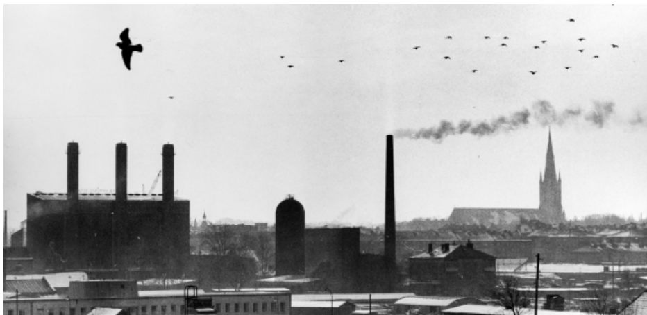
Det nya Kraftvärmeverket 1964 innebar en ny Linköpingssiluett
