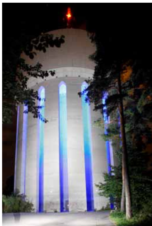
Vattentornet i Berga hage
