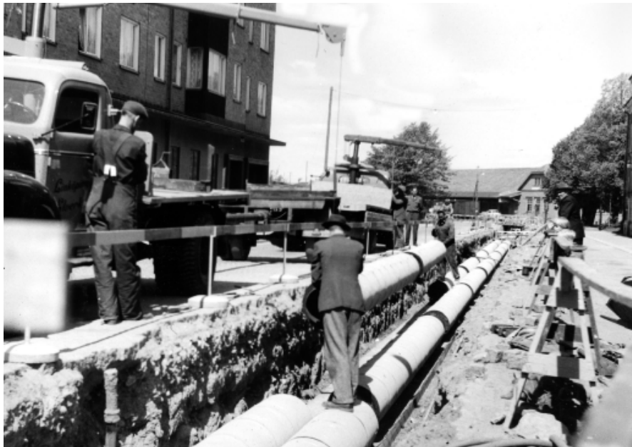
Byggandet av nya fjärrvärmeledningar 1954 i S:t Larsgatan.
