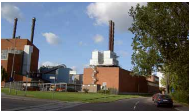
Fjärrkylacentralen i anslutning till Kraftvärmeverket
