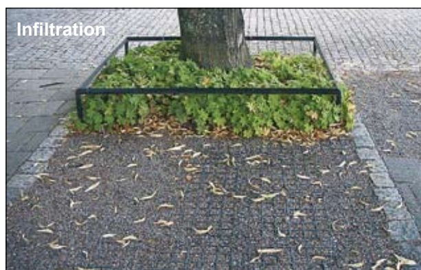
Genomsläpplig yta mellan träden i en trädrad. Ytan består av grus och rasternät som minskar kompakteringen av ytan och bibehåller infiltrationsförmågan. Uppsala. Foto VegTec.
