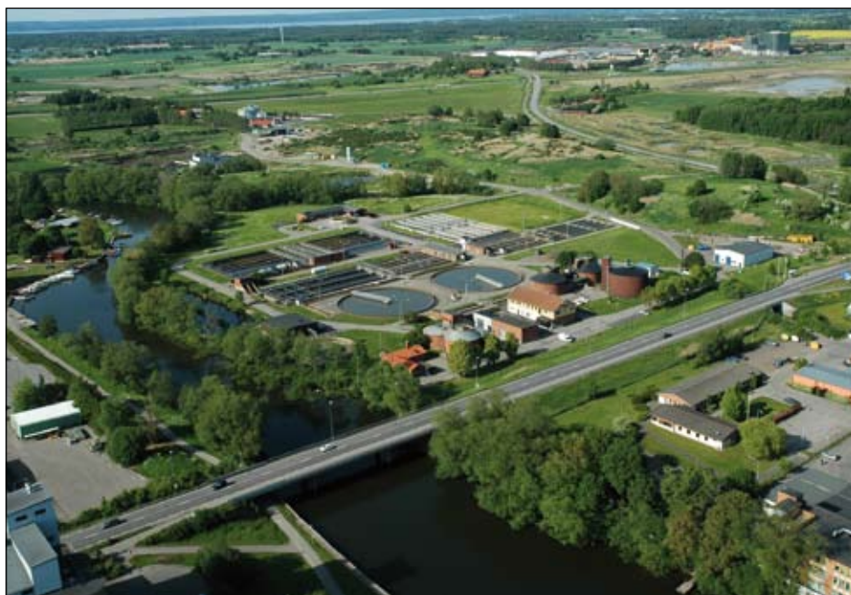
Översikt Nykvarnsverket mot norr. Biogasanläggningen vid Åby i bakgrunden.
