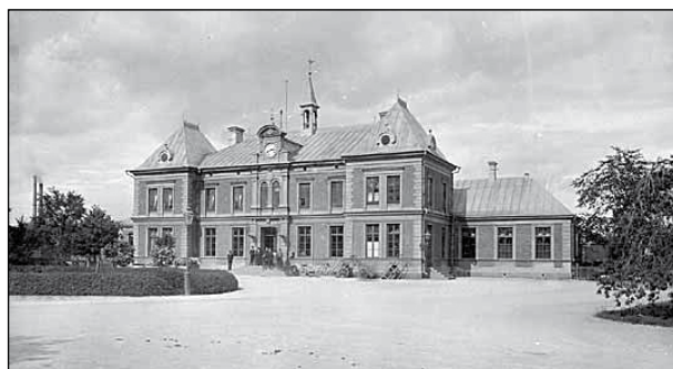
Järnvägsstationen, byggd 1872. Här ser vi hur stationsmiljön såg ut 1904
