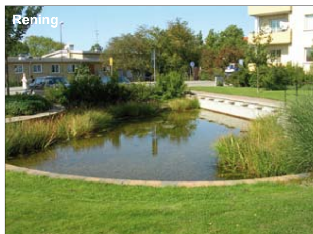
I en sedimentationsdamm faller partiklar ner på botten som måste rensas då och då. Augustenborg, Malmö. Foto Tyréns. Ett problem vid öppna vattenytor är den algbildning som sker. Ytterligare studier behöver göras
