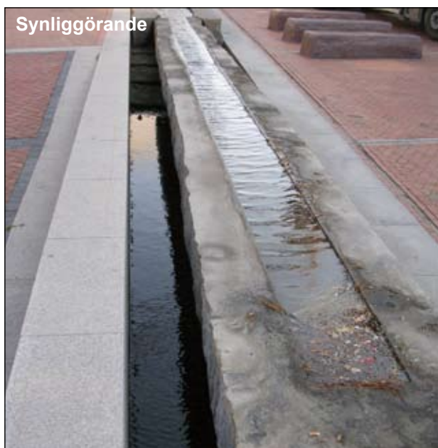
Västra hamnen Malmö, foto Tyréns. Även i innerstadsmiljö kan dagvatten synas och vara en tillgång i miljön.
