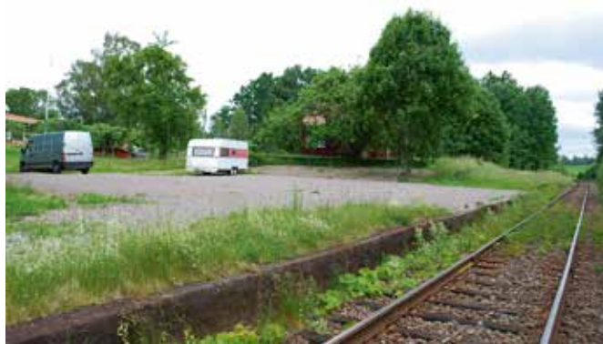
Stationsområdet ligger mitt i samhället. Stationshuset är rivet och kvar finns bara perrongerna.
