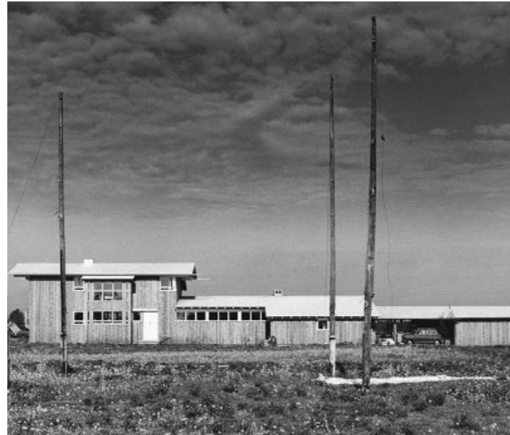
Fiskarens hus, Boda, Öland. Arkitekt: Jan Gizelius. Bostad till fiskarfamilj anpassat till lokal byggnadstradition. Sammanbyggd bostad och fiskerilokaler.
